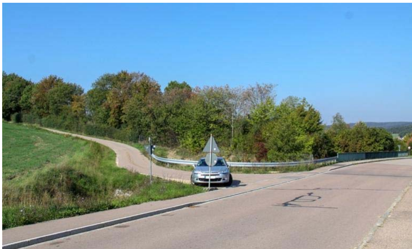
An der Brücke nach Probstberg endet bzw. beginnt die Südspange, die zunächst im Zuge des B16-Ausbaus als Baustraße realisiert wird. Fotos: msr
