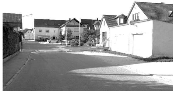
Foto Straßenraum und Bereich vor dem Feuerwehrhaus
