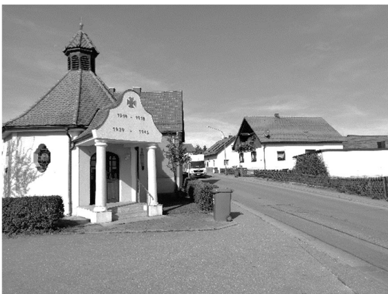
Foto: Blick auf die Kapelle und Brandlbergstraße (Bestand)
